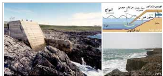
شکل ۴ | دستگاه لیمپت OWC، فرآیند تولید و امکان‌سنجی در سواحل ایران
