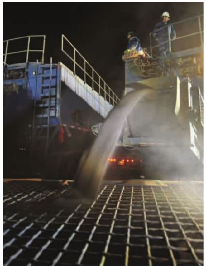
۴ | پروپانت در حال تخلیه به داخل قیف برای انتقال به تراک اختلاط است. مخلوط به داخل چاه جهت شکاف هیدرولیکی پمپ می‌شود
