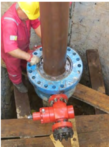
شکل ۳۰ | نصب 9-5/8" CSG SLIPS غیر اتوماتیک درون C.H.H
