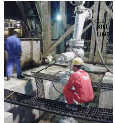
شکل ۵ | گروه تاج چاه در حال باز کردن شیر ایمنی سطحی
