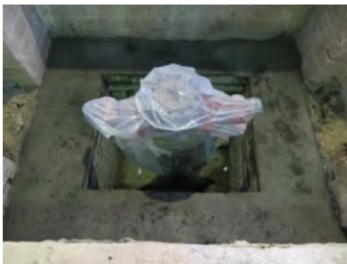
تکمیل عملیات نصب فورانگیرها و برپایی تاج چاه ۳۳ و ۳۲
