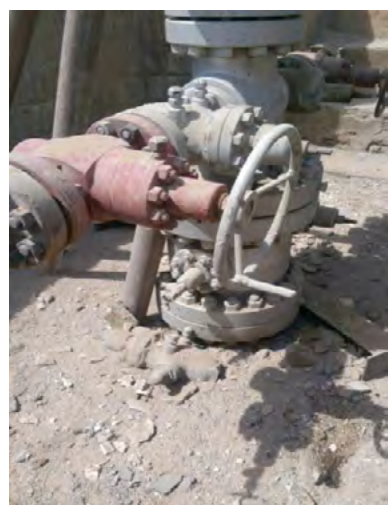
شکل ۲ | شکستن شیرهای جانبی متصل به فلنج مینا
