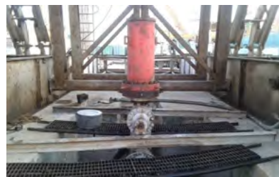
شکل ۹ | نصب تبدیل 5K-5/8"-13-3K-6 DSA و Spacer Pool
