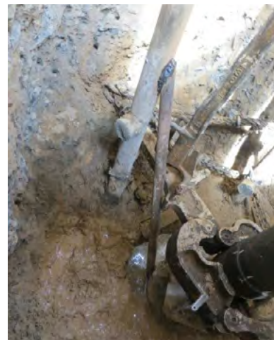
شکل ۲۸ | جوشکاری لوله "۲ فشار قوی به جداری "۲۰ و شمع
