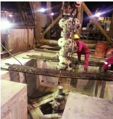
بلند کردن TBG HD SPOOL به همراه BTM MASTER TOP MASTER VALVE و VALVE از تاج چاه و مشاهده 7"NECK
