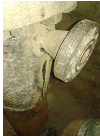
شکل ۱۱ | جوشکاری ورق بین فلنج مبنا و جداری ۱۳-۳/۸" و فلنج به خروجی‌های فلنج مبنا
