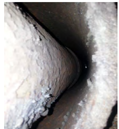
شکل ۲۶ و ۲۵ | مشاهده کوپلینگ جداری "۹-۵/۸ و تعمیق گودال تا رسیدن به آن
