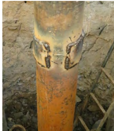
شکل ۲۷ | جوش دادن دو شاخه به یکدیگر
