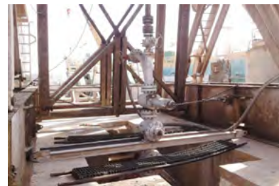
شکل ۸ | قرار دادن دو عدد H-Beam زیر Top Master Valve
