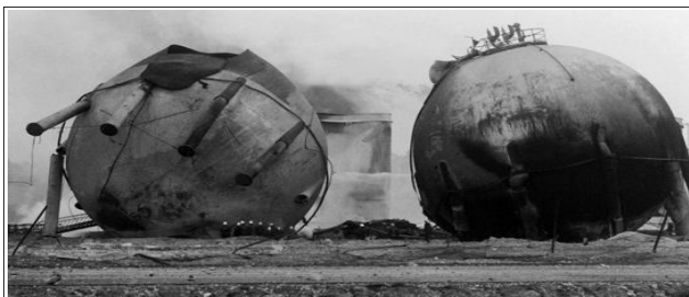
شکل ۴ | انفجار مخازن پروپان در حادثه‌ی فیزن در فرانسه - ۱۹۶۶
